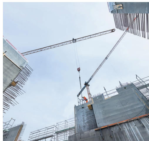
Impression betonierter Wandetappen
