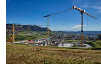
18) Baustellenübersicht mit drei Baukränen I
