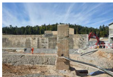
14) Abbrucharbeiten und Provisorien
