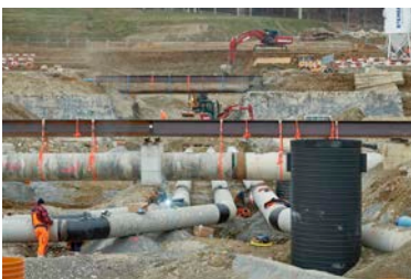
07) Neue Transportleitung und Provisorien
