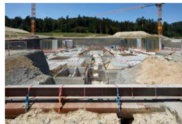
04) Vertiefungen, Bodenplatten und Baugrubensicherung
