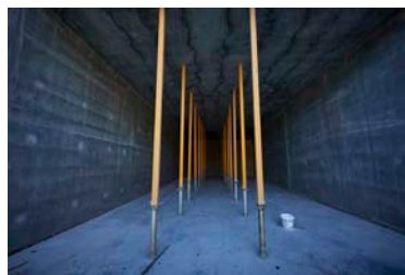
20) Einzelne Deckenträger bis zur fertigen Aushärtung
