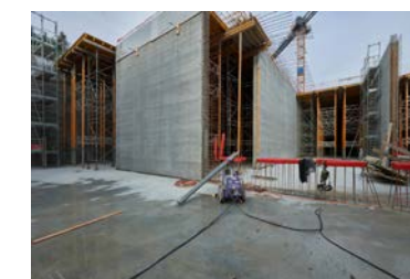
17) Deckenschalungen über Wasserbehälter
