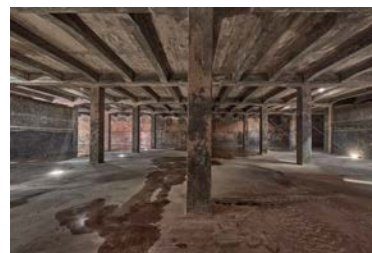
09) Alte Reservoirbehälter vor Abbruch II
