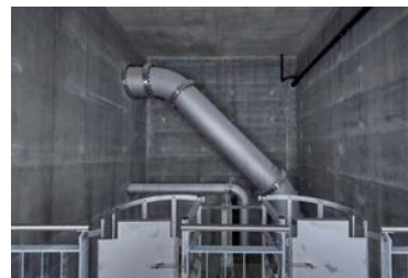
10) Auslaufschacht mit Überlauf Zufluss Emmental
