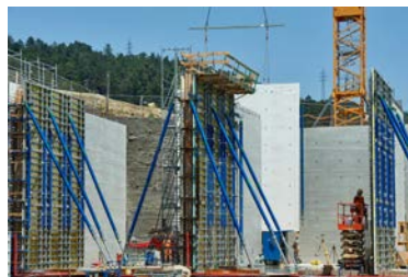
03) Wandschalungen mit Arbeitsgerüst
