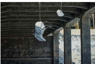
13) Impression während Abbrucharbeiten
