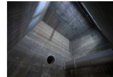
11) Zulauf Emmental in Einlaufbehälter mit Überlauf
