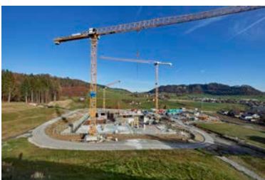
19) Baustellenübersicht mit drei Baukränen II
